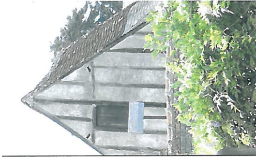
Pan de bois remplissage en torchis
