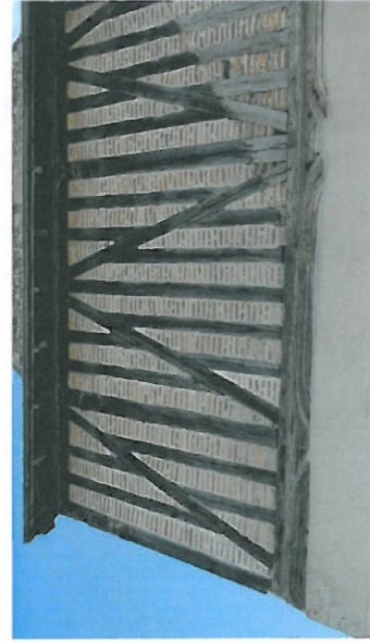
Pan de bois remplissage en brique
