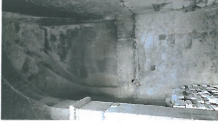
Le cloisonnement sous la Tour Saint-Paul
