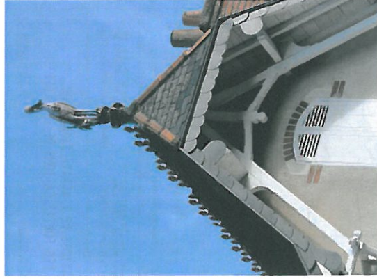
Pignon couvert d'un couverture en demi-croupe en débord, portée par une ferme d'avant-corps
