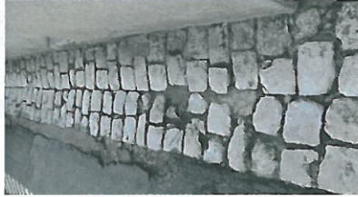
Fil d'eau, trottoirs, bordures... en pavés calcaires
