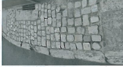
Fil d'eau, trottoirs, bordures... en pavés calcaires
