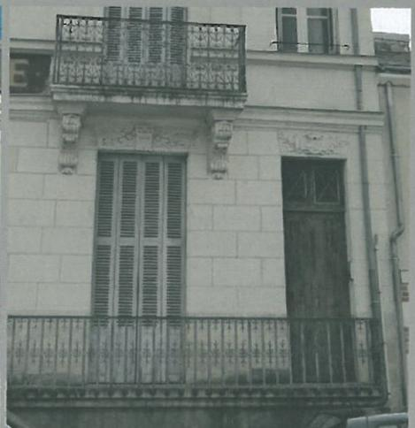
*Les pierres en tuffeau des façades en pierres ou des chaînes d'angles et encadrement de baies sont souvent de taille plus régulière et lisse. Dans ce cas, et si le reste de la façade est destiné à être enduit, un enduit lissé apposé au nu de la pierre, sera plus approprié.*
