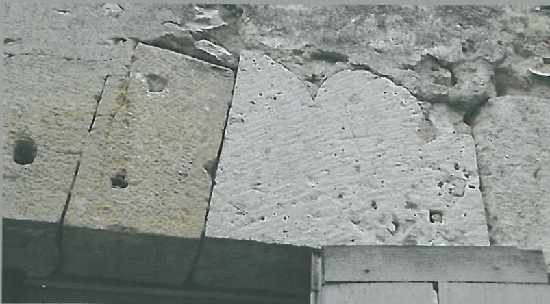
*De nombreux remploi de matériaux, (souvent des vestiges des bâtiments de l'abbaye démolis se retrouvent dans les structures. (Remploi d'une pierre de pile à colonnettes ?)*
