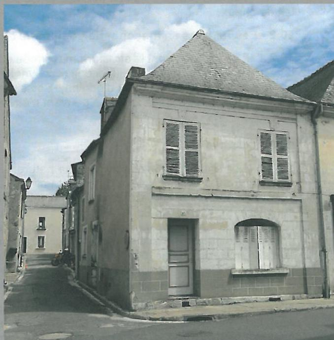
*Façade sur laquelle il n'est pas envisageable d'apposer une isolation par l'extérieur : présence de modénatures de pierre, (appuis de fenêtre, bandeau d'étage, corniche)*
