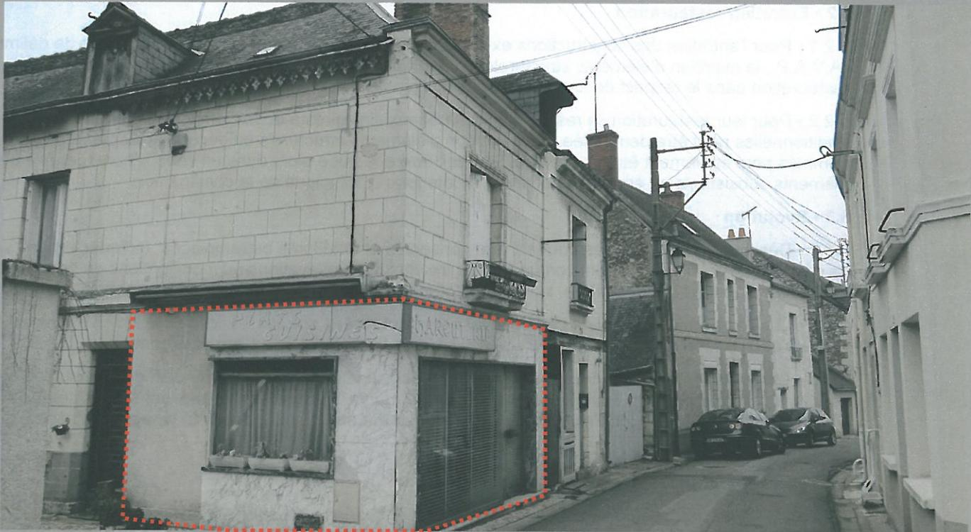
*Autre exemple d'éventrement d'un rez de chaussée déséquilibrant la composition de la façade et dénaturant le chaînage d'angle en pierre de taille.*
