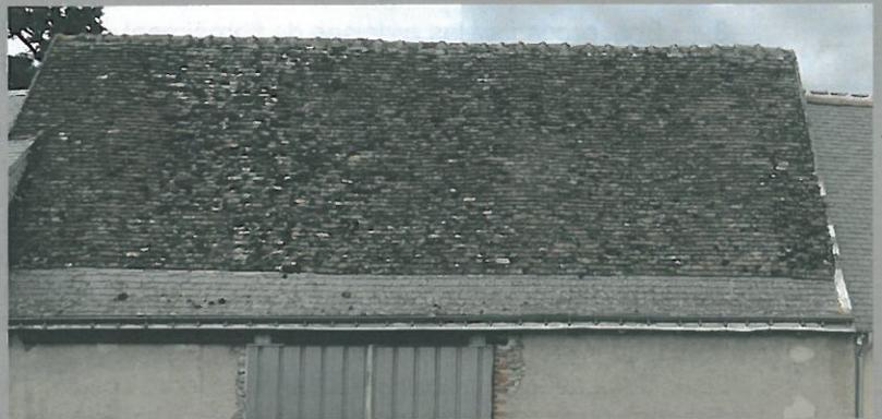
*Les petites tuiles plates, matériau local à privilégier sont progressivement remplacées ou partiellement remplacées par des ardoises, ces dénaturations de toitures couvertes de matériaux bigarrés sont à éviter.*
