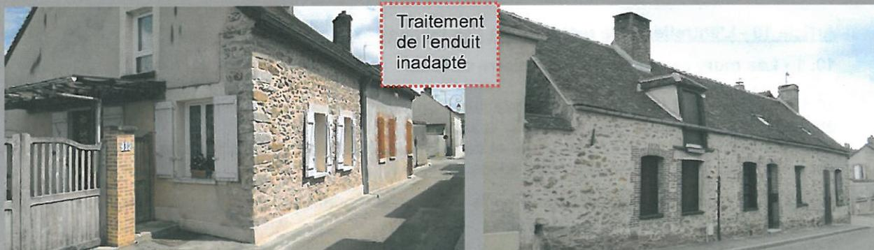
*Les maçonneries en moellons sont destinées à être enduites et non découvertes. Seuls les murs de clôture, les pignons aveugles n'étaient, autrefois, enduits qu'à « pierre vue », par économie..*
