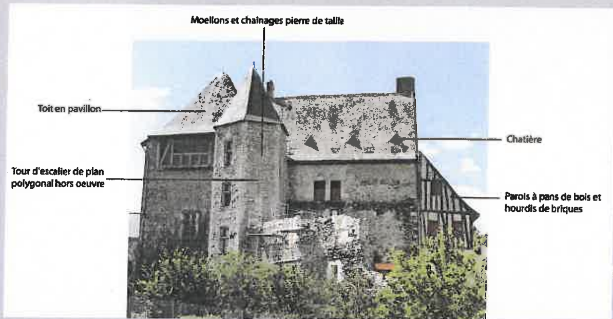
Le logis de l'Abbé. le haut comble du Logis principal laissant supposer une charpente remarquable
