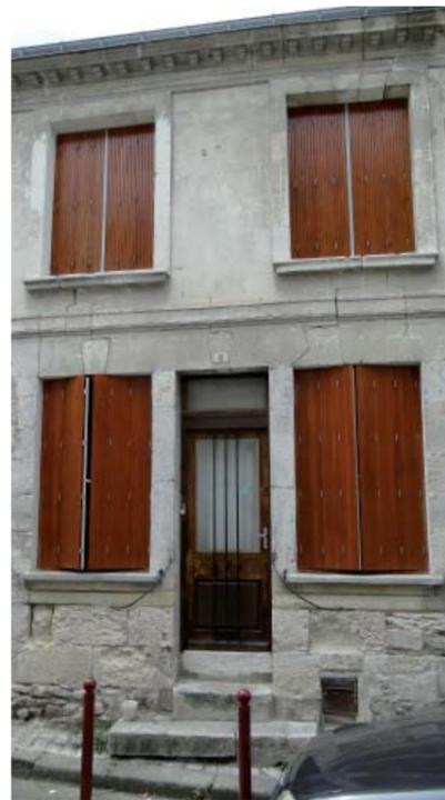
Pratique nuisible des enduits ciment et peintures plastiques étanches, imperméables, ne laissant pas respirer les maçonneries
