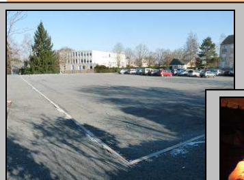
Le 30, parking terminé
