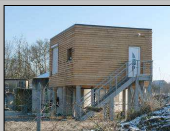
Station d'épuration terminée
